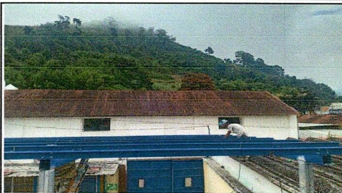
Foto: 2 Mejoramiento de estructura de techo
