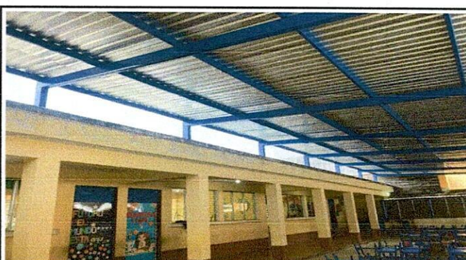
Foto: 4 Instalación de techo con lamina troquelada
