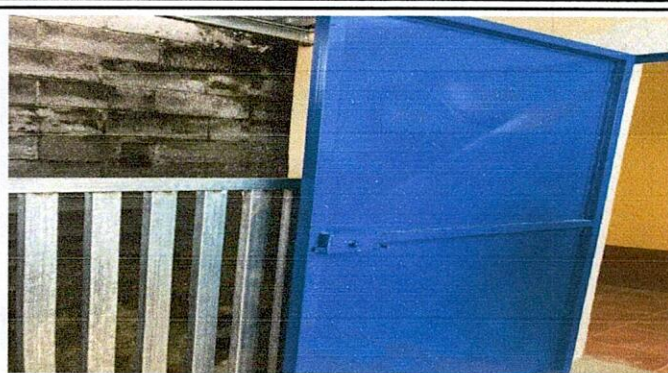
Foto: 8 Instalación de puerta metálica
