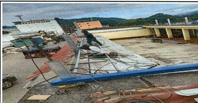
Foto: 1 Mejoramiento de estructura del techo
