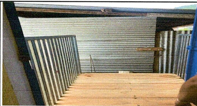
Foto: 7 Instalación de Puerta metálica
