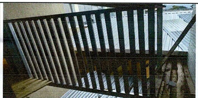
Foto: 5 Mejoramiento de rampa de acceso de un módulo a otro
